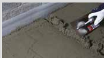
Au minimum 15 jours après la coulée et après vérification du taux d'humidité du béton léger, le revêtement de sol peut-être posé et/ou collé : - directement sur le béton léger à l'aide d'un mortier-colle C2-S1 (carrelage), - sur un enduit de ragréage classé P3 intermédiaire (moquette, PVC, parquet).
