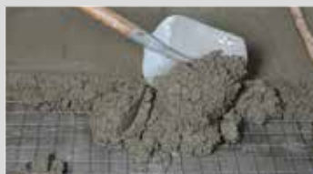
a- Chape légère Sur planchers bois : Treillis obligatoire disposé au milieu de la chape (maille 50 mm x 50 mm x 1,4/1,8 mm). Laisser sécher.
