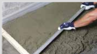
b- Appliquer le béton en une couche de minimum 4 cm et l'égaliser à l'aide d'une règle.
