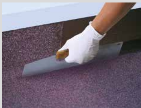
5- Finition (optionnelle) par application au platir de paillettes d'ardoises colorées.
