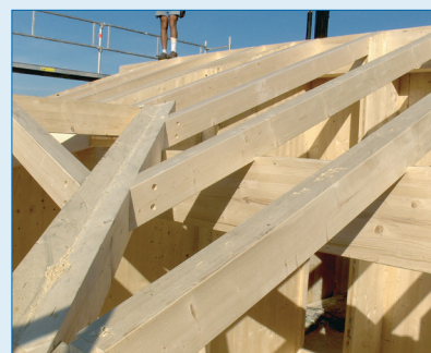
Jonction poutre principale-secondaire
