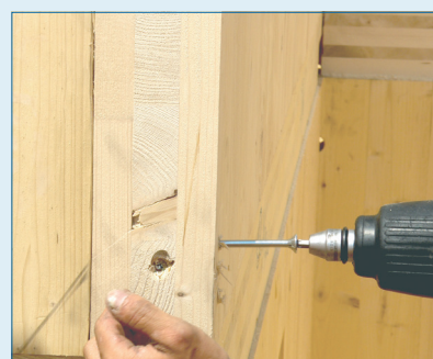
Raccord d'angle entre deux murs
