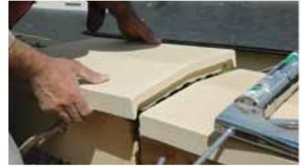
Écraser ce cordon jusqu'à former un joint de 1 à 2 mm entre les chaperons. En extrémité de mur, réaliser une coupe pour supprimer l'emboîtement.
