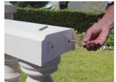
Mettre en place la lisse basse sur une assise de 2 à 6 cm de mortier et poser des balustres avec joints de 5 mm au mortier Weser-Mix JM. Sceller les clavettes entre lisses et trumeau.
