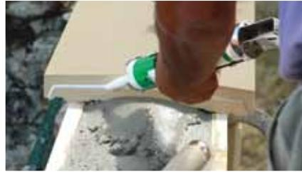
Appliquer sur la partie mâle un cordon de joint élastomère type acrylique. Le cordon doit être appliqué au delà de la goutte d'eau pour éviter les coulures sur le mur au droit du joint.
