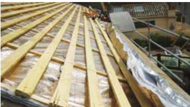
Parois isolées : Toiture par l'extérieur
