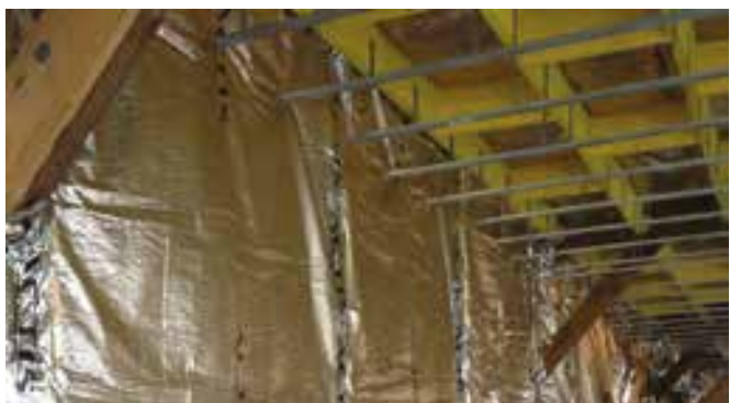
Parois isolées : Murs par l'intérieur en complément de panneaux de SYLVACTIS 40 FX
