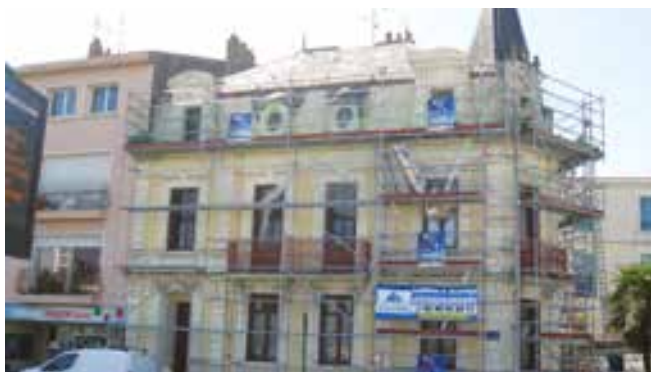
Rénovation d'un immeuble en Vendée (85)
