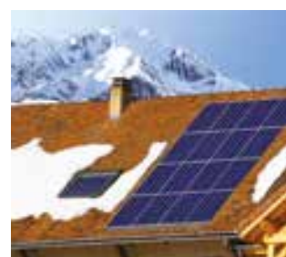
Bâtiment mal isolé
