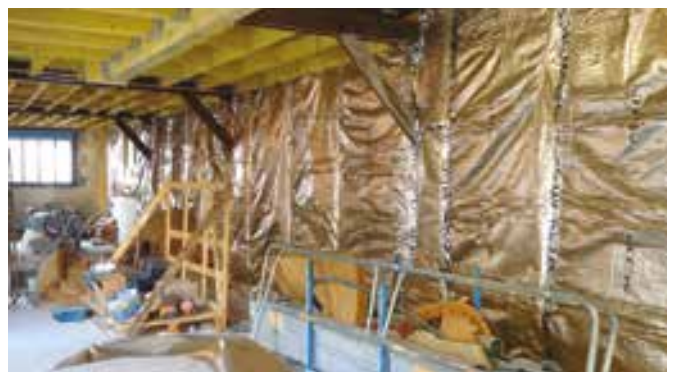
Rénovation d'une habitation à Paris (75)
