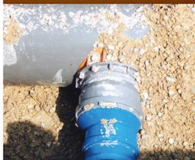
Le raccord de piquage CONNEX permet un raccordement simple et rapide et offre une angulation jusqu'à 11°. Il s'adapte sur les tuyaux lisses à parois minces les plus courants d'une épaisseur de 3 à 15 mm.
