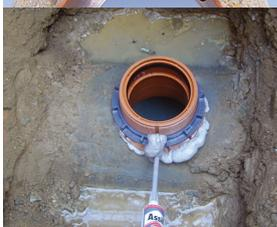
Un moyen efficace d'effectuer un branchement étanche durable. Nous conseillons d'utiliser le tuyau HSK pour le branchement.
