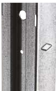
4 traits de niveau situés à 1 m du sol fini
