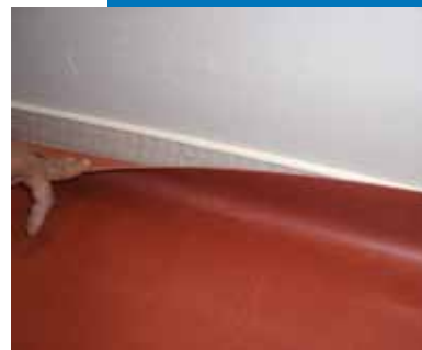
Affichage puis marouflage du revêtement de sol
