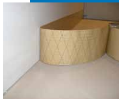
Application de Mapecontact Plinthes (85 mm) au mur.
