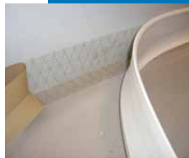
Après retrait du papier protecteur, affichage de la remontée en plinthe complète semi-rigide
