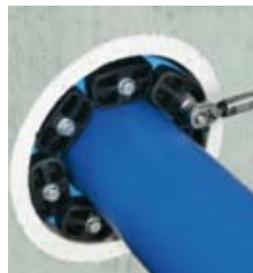
6. Effectuer alternativement 4/5 tours de vis jusqu'à atteindre le couple préconisé. L'aspect de l'élastomère doit être uniforme sous chaque plaque de pression.
