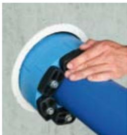
4. Insérer le joint dans l'espace annulaire. Commencer par la partie supérieure puis la partie inférieure pour finir par les côtés.
