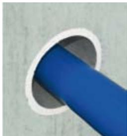
1. Centrer la canalisation dans l'orifice de la paroi.
