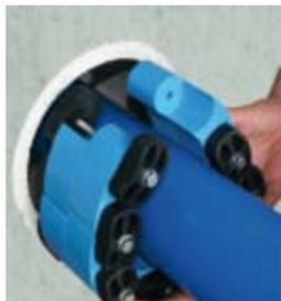
2. Placer le joint autour de la canalisation et joindre les deux extrémités. S'assurer que toutes les têtes de vis font face à l'opérateur.
