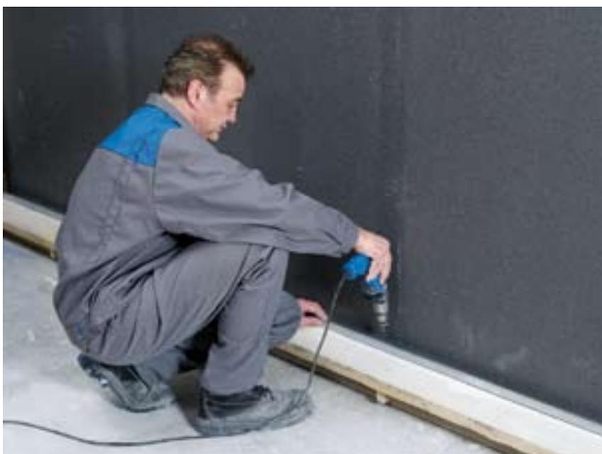
6. Vérifier l'étanchéité à l'air. Eventuellement, combler avec un mousse PU ou un adhésif aux joints. Puis, clipser la fourrure.
